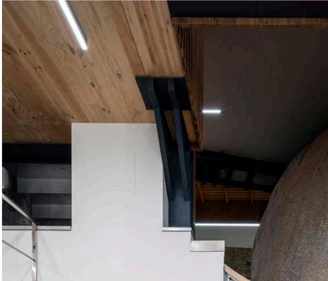
Detalle de mecanizado de panel de CLT con CNC no BUO de Muiños © MOL Arquitectura
