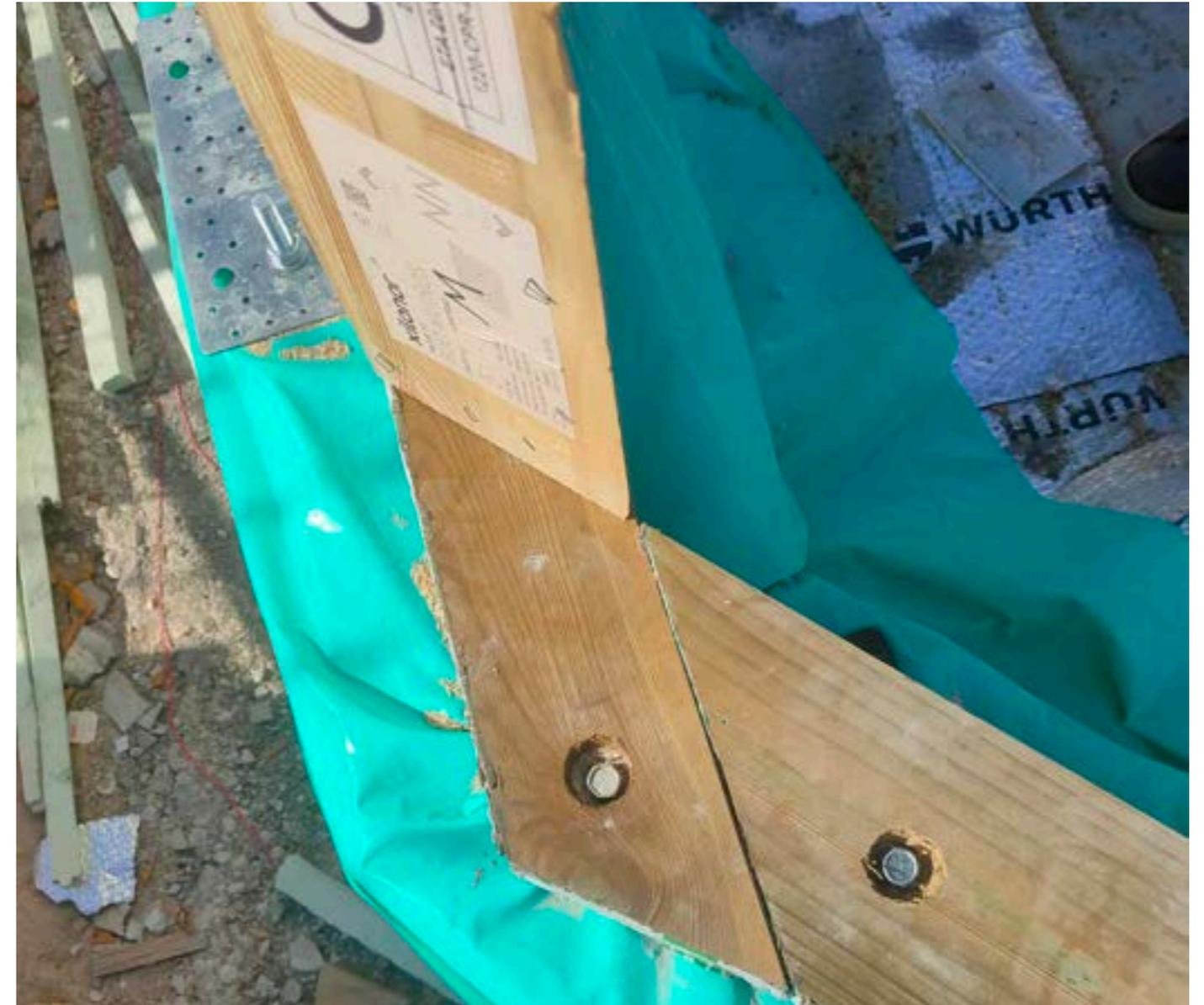
Imaxe da membrana impermeable e transpirable da estrutura de CLT © MOL Arquitectura
