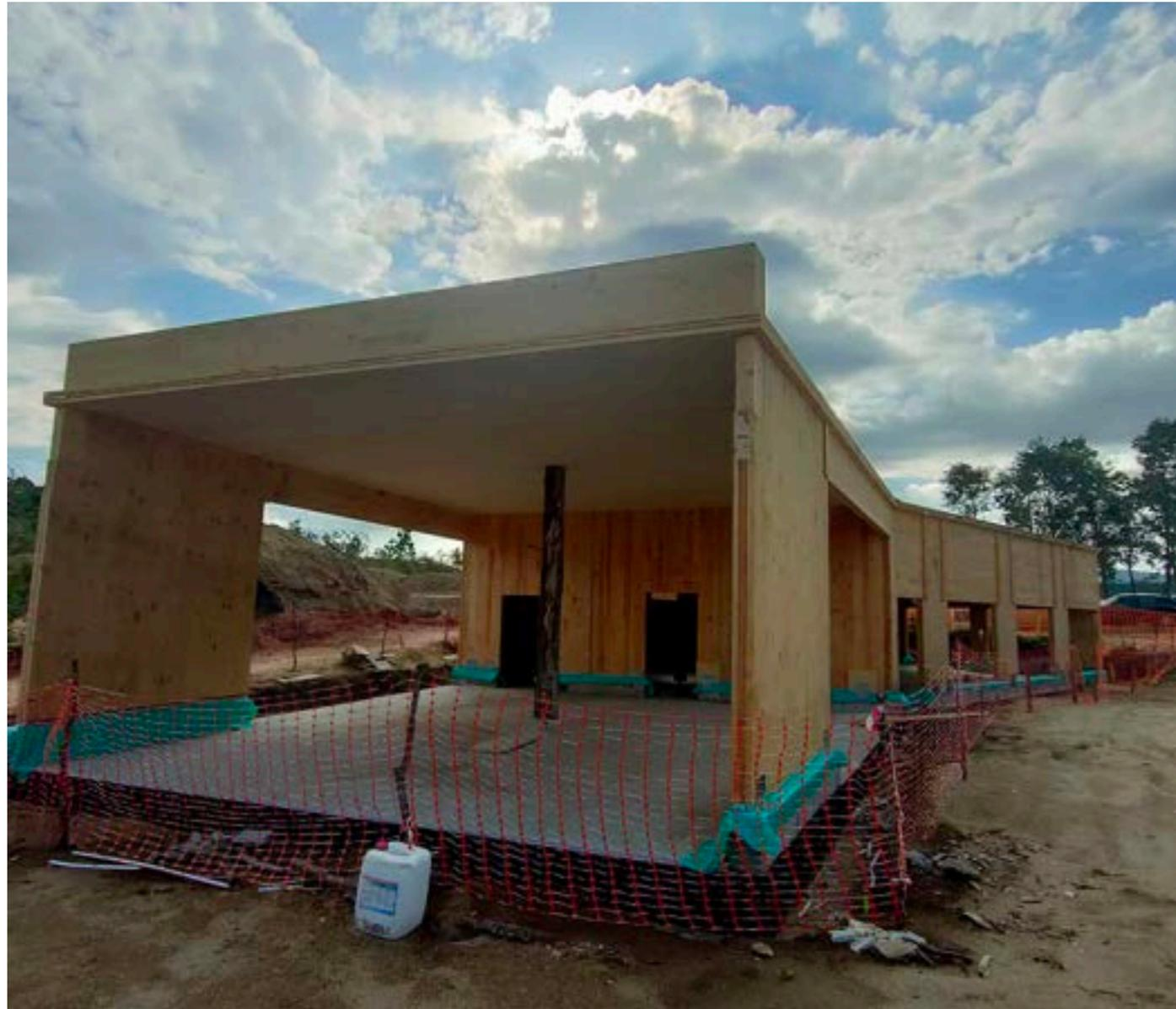
Detalles da membrana antitermitas da estrutura de CLT © MOL Arquitectura
