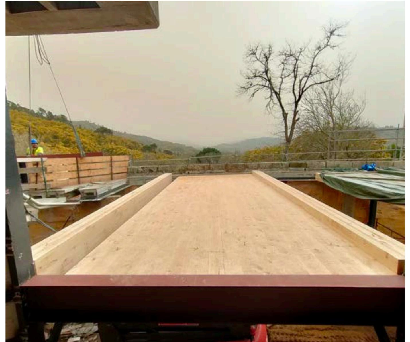
No deseño destes tipos de estruturas, con xeometrías menos regulares contamos coa ferramenta de CNC para resolver as unións e para, en base aos formatos máximos de paneis, de dimensións máximas de 12x3m no caso de Xilonor, facer un despiece co maior aproveitamento e menor desperdicio de material.
