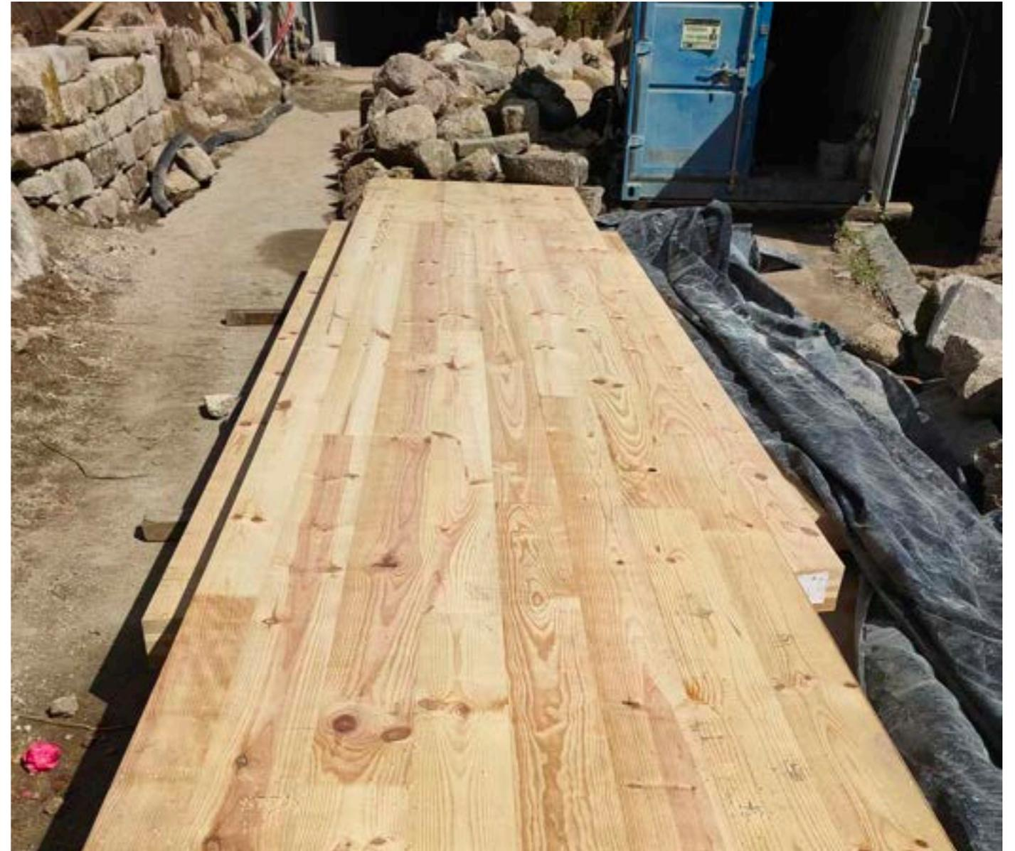
Este emprego das estruturas de CLT require unha maior definición na fase de proxecto, xa que de fábrica os paneis saíran cun gran nivel de precisión construtiva, listos para a súa colocación directa en obra.
