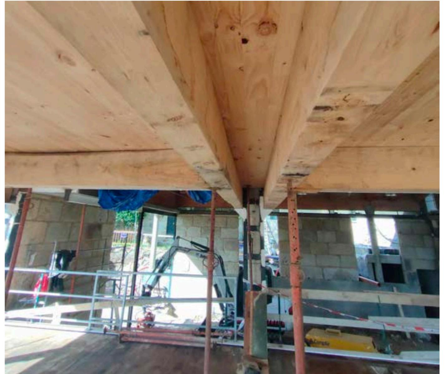
á hora de deseñar e de executar a estrutura, como son a desolidarización entre distintos materiais coas membranas adecuadas, e nos casos nos que a estrutura non actúe simplemente pousada no soporte non actúe simplemente apoiado, anclar segundo o cálculo das unións, co dimensionamento adecuado de pernos e de chapas de anclaxe.
