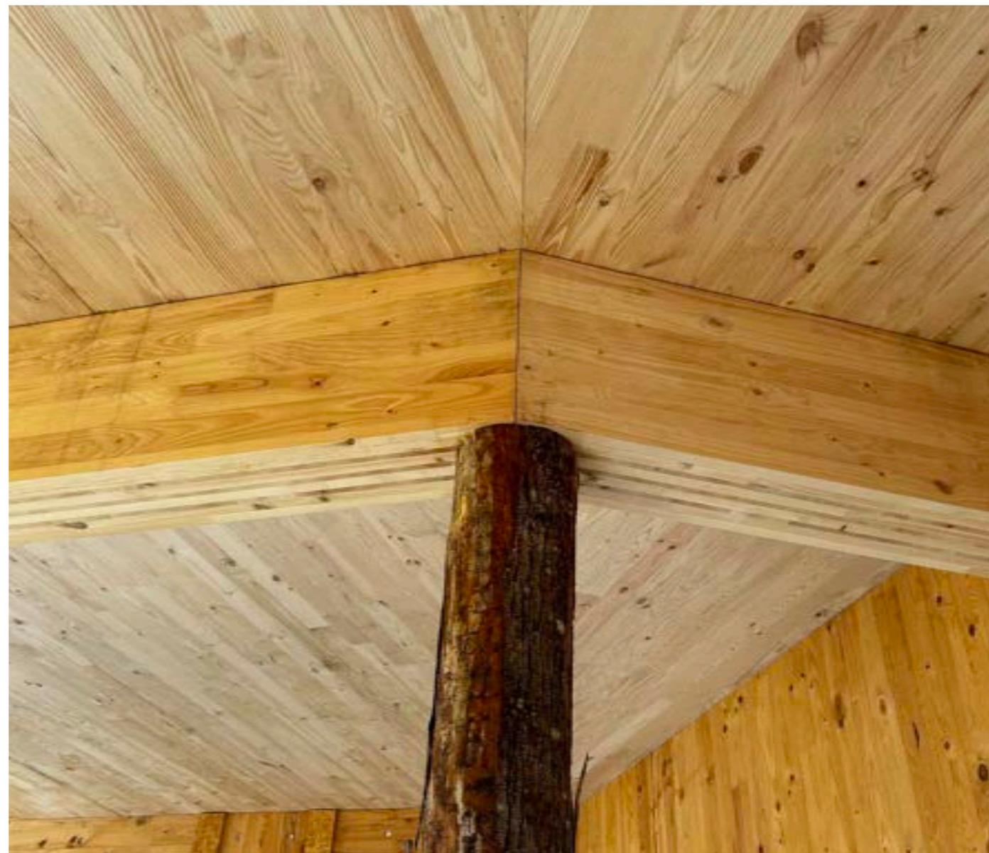
Detalle da estrutura de CLT © CIS-Madeira
