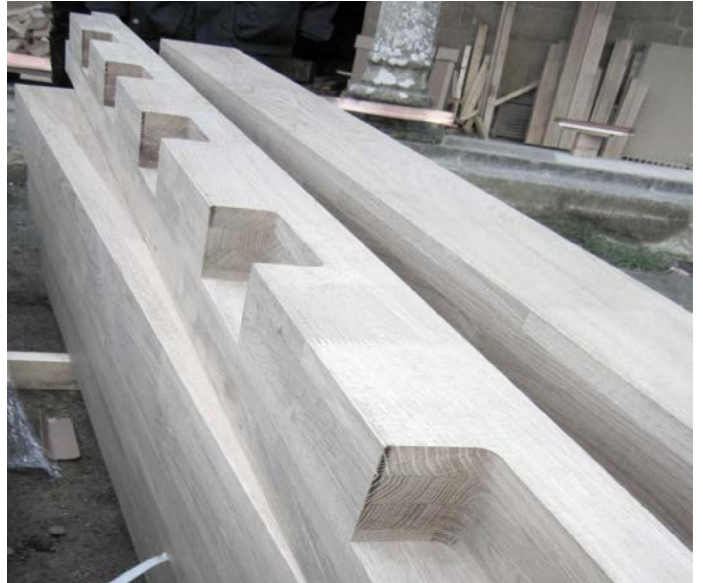
Caixeado de vigas, Castelo de Monterrei, Ourense © Ezcurra e Ouzande Cajeado de vigas, Castelo de Monterrei, Ourense © Ezcurra e Ouzande Mortiser bit, Castelo de Monterrei, Ourense © Ezcurra e Ouzande
